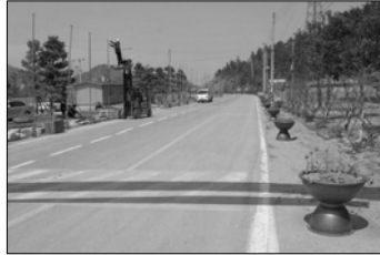
가로에 화분이 배치되어 있으나 식물이 제대로 식재되어 있지 않아 효과가 미흡
