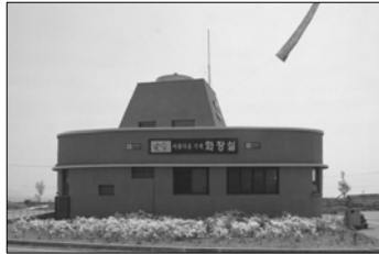
건축물의 형태나 색채 등이 주변과 조화를 이루지 못한 화장실
